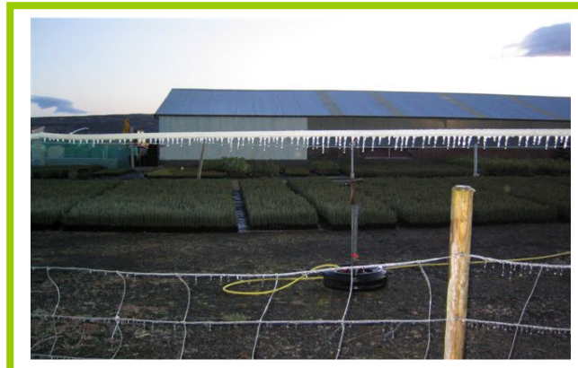
Hér sjáum við frostsprungna úðara og grýlukerti á qirðinum.
