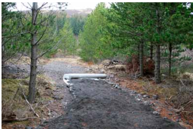
Nýir skógarstígar hafa verið lagðir um Haukadalsskóg síðustu tíu ár og hér má sjá stíg í lagningu neðan við Svartagilshvamm.
