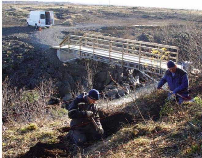
Jóhannes verkstjóri og Þróstur Ingvarsson vinna við skábraut frá nýju brúnni yfir Sandá að skógarstígnum í Gvendarrana. Ljósmynd: Hreinn Óskarsson.
