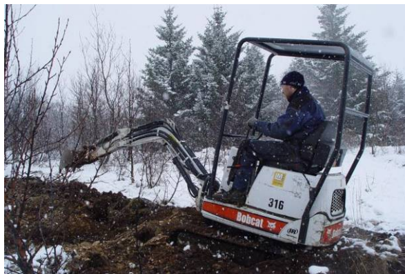
Jóhannes grefur fyrir nýrri hitavatnslögn í Haukadall. Ljós. Hreinn Óskarsson
