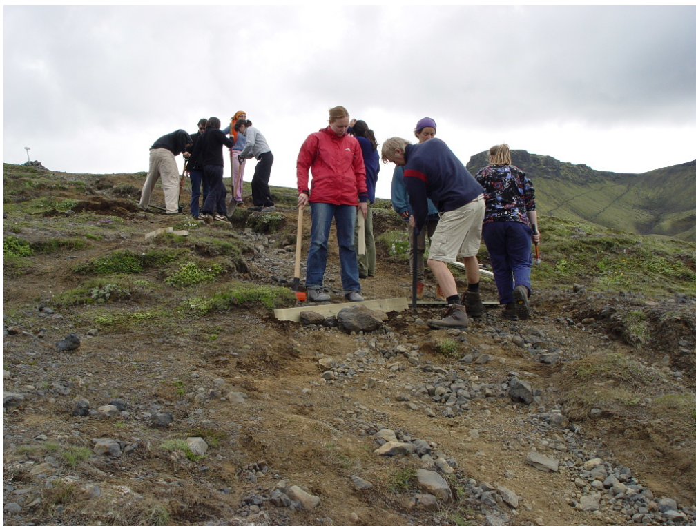
Hópur sjálfbóðaliða frá Veraldarvinum lagfæra stíginn upp á Fimmvörðuháls ofan Kattahryggja.
