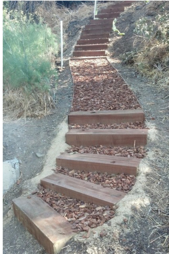
Tillaga að þrepum / ómeðhöndlaður íslenskur viður, náttúrulega fúavarinn, þolir íslenska veðráttu á heiðum uppi og þarfnast lítils viðhalds. Á milli þrepa er sama efnisval og lagt verður í göngustíginn / skábraut.
