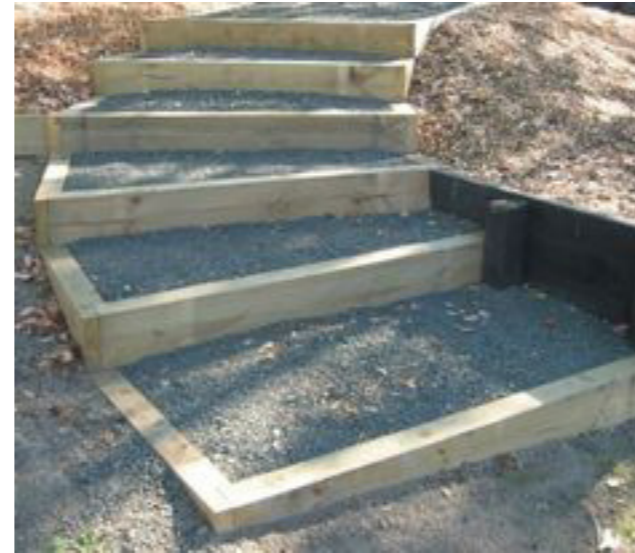
Tillaga að þrepum / ómeðhöndlaður íslenskur viður, náttúrulega fúavarinn, þolir íslenska veðráttu á heiðum uppi og þarfnast lítils viðhalds. Skúffur lagðar og fylltar með samsvarandi efnisvali og er í göngustíg / skábraut.
