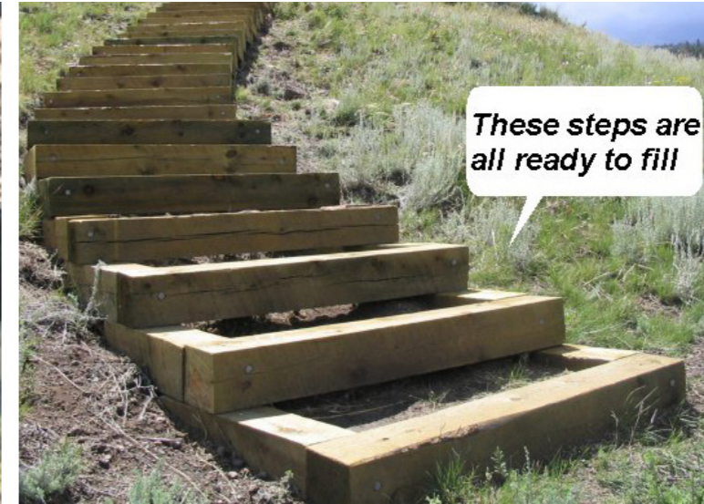
Tillaga að þrepum / ómeðhöndlaður íslenskur viður, náttúrulega fúavarinn, þolir íslenska veðráttu á heiðum uppi og þarfnast lítils viðhalds. Mynd sýnir hvernig skúffur eru samsettar í beinu flæði.
